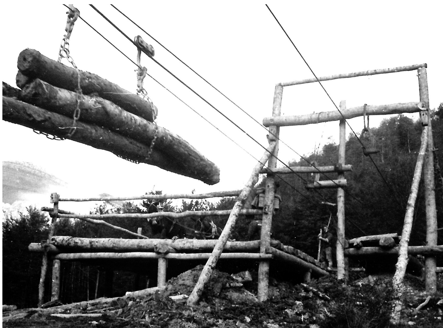
Egurra kablean zintzilikatzeko kargalekua. Bixente Eskisabel ataundarrak halako instalakuntzak eraiki zituen. KABLEGINTZA.WORDPRESS.COM
